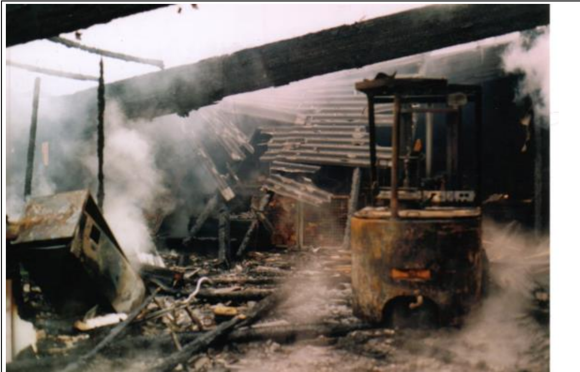
Am 23. September kam es vermutlich durch Brandstiftung in der Druckerei Wührer im Gewerbegebiet zu einem Brand. Durch das Feuer wurde das Gebäude stark beschädigt und mehrere Maschinen zerstört.
